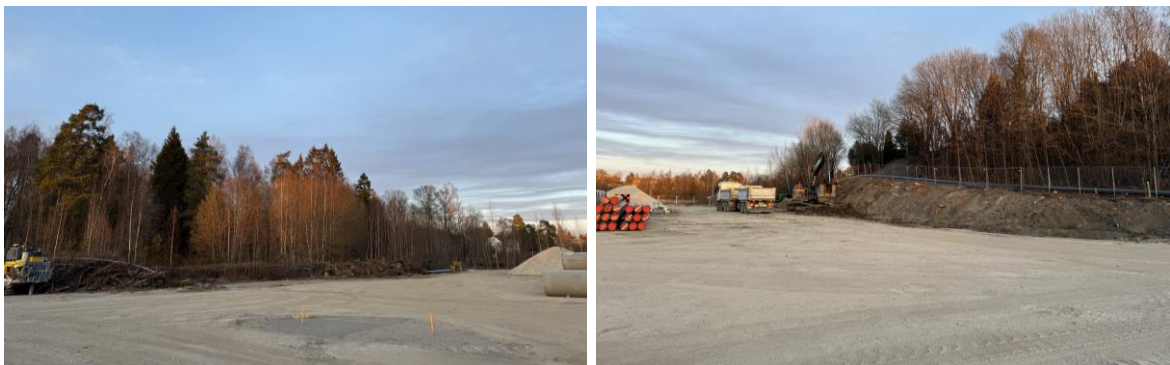
Figur 1: Bildene viser området slik det var på befaringstidspunktet i november. Bildet til venstre er tatt i retning nordvest mot den vegeterte delen av B4, mens bildet til høyre er tatt i retning sørøst og viser den oppgravde grøften til VA.
